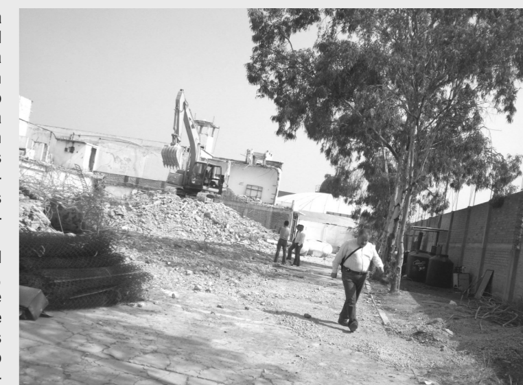
La maquinaria pesada trabaja demoliendo uno de los centros de reclusión que gestionó el ex presidente municipal licenciado Eleazar García Rodríguez.
